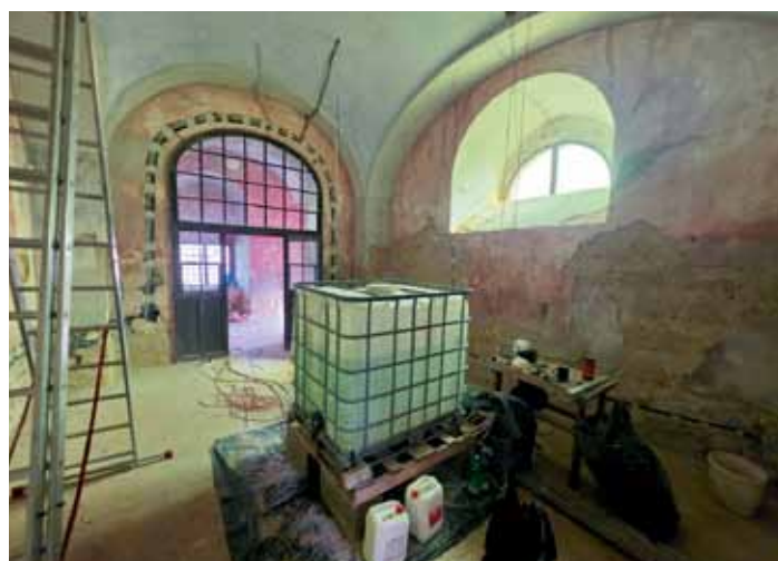
Nyní probíhá výměna elektroinstalace a rekonstrukce prostor v sakristii kostela
