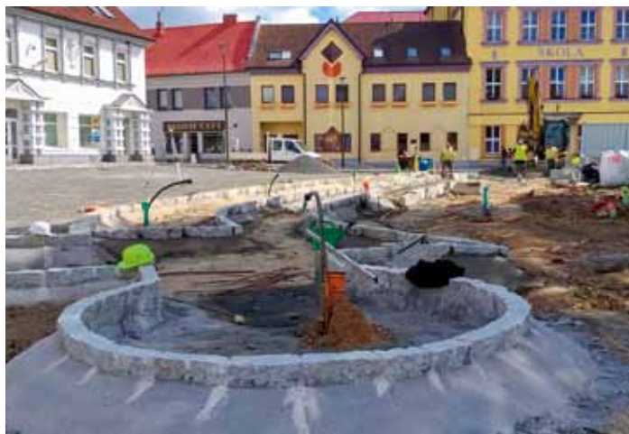
Revitalizace náměstí T.G.M. – Dokončeno je dláždění. Poslední etapa je park uprostřed náměstí – září 2026
