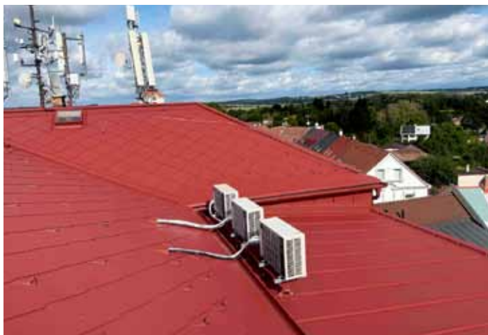
Rekonstrukce střechy ZŠ – pohled na část do Ulice Školní, září 2026
