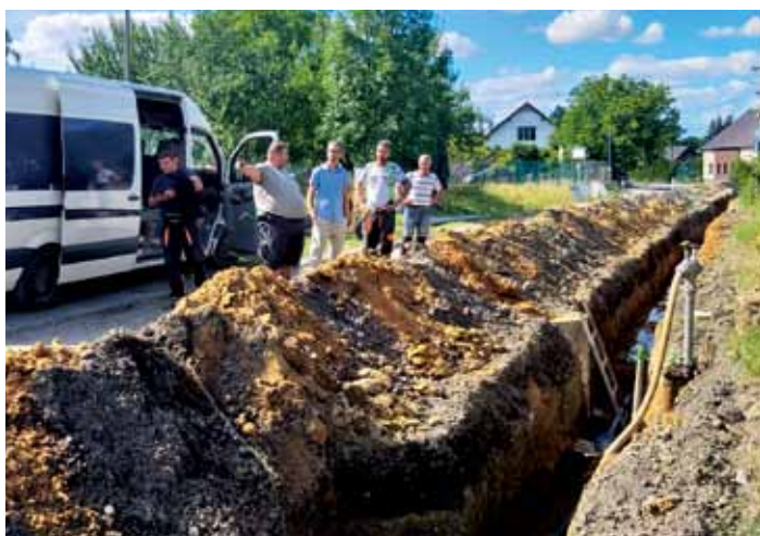
V srpnu začala rekonstrukce Vlčopolské ulice. Po odfrézování asfaltového povrchu se provádí výměna vodovodního řadu včetně domovních uzávěrů
