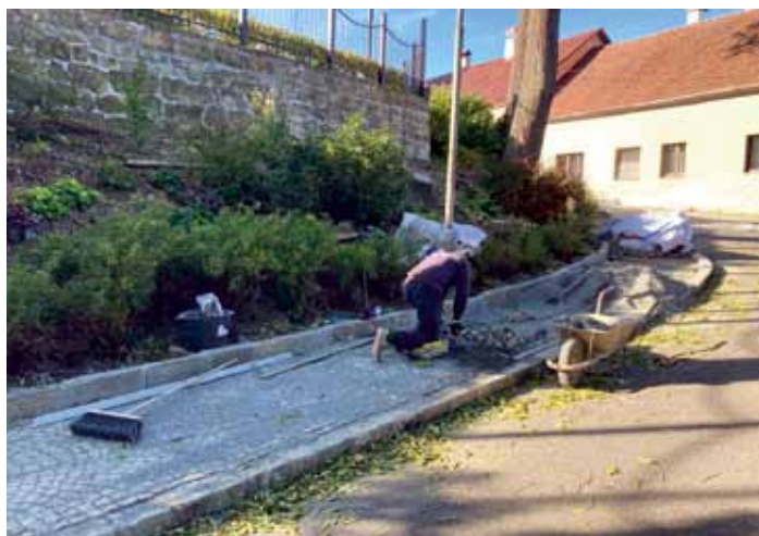
Oprava chodníku v ulici Na Školništi naproti domu s pečovatelskou službou. Chodník bude kompletně předlážděn, povrch žulová mozaika a žulová kostka.
