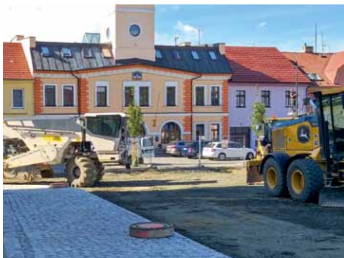
Revitalizace náměstí T.G.M. – Těžkou technikou byl zhutněn podklad pod asfaltový povrch silnice do Dlouhé ulice – září 2026
