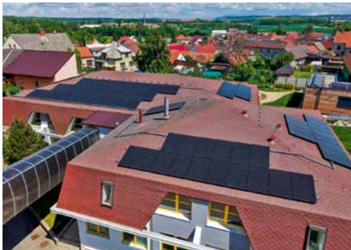
Fotovoltaika - ZŠ (sportovní hala)
