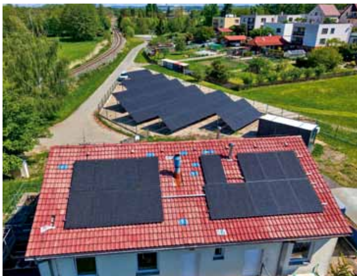
Fotovoltaika na ČOV je dokončena
