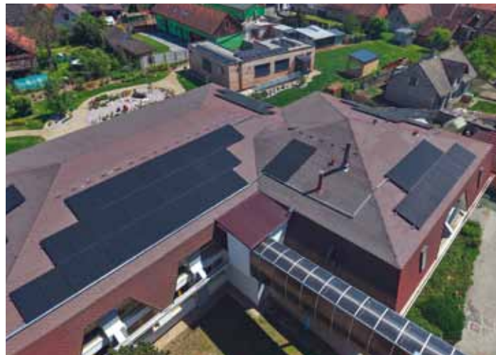
Panely na střeše sportovní haly ZŠ jsou pro vyšší efektivitu orientovány do více světových stran.
