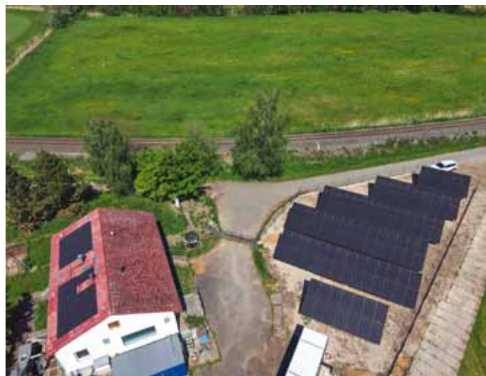
Panely v areálu čističky odpadních vod
