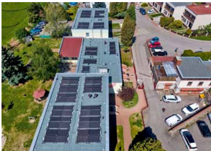
Fotovoltaické panely jsou i na budově mateřské školy v Zahradní ulici
