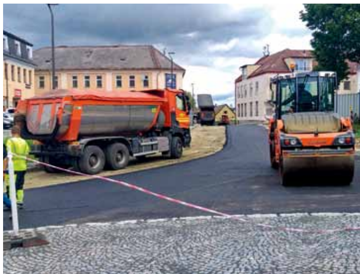
Rekonstrukce náměstí T.G.M. - 6. a 7. července 2026 byl položen ve dvou vrstvách asfaltový povrch na zprůjezdění hlavního tahu náměstím.
