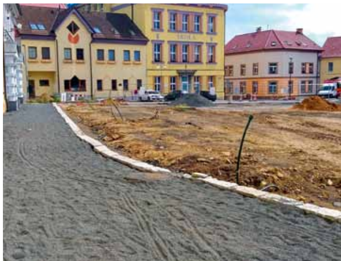
Rekonstrukce náměstí T.G.M. - pokračuje další etapou na severní části náměstí červenec 2026
