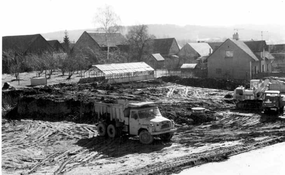
Poslední zbytky školního skleníku v r. 1996 před zahájením stavby sportovní haly
