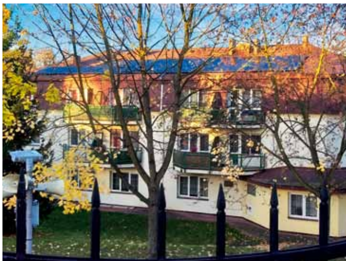
Instalace fotovoltaických panelů byla dokončena na další budově v majetku města – DPS listopad 2025
