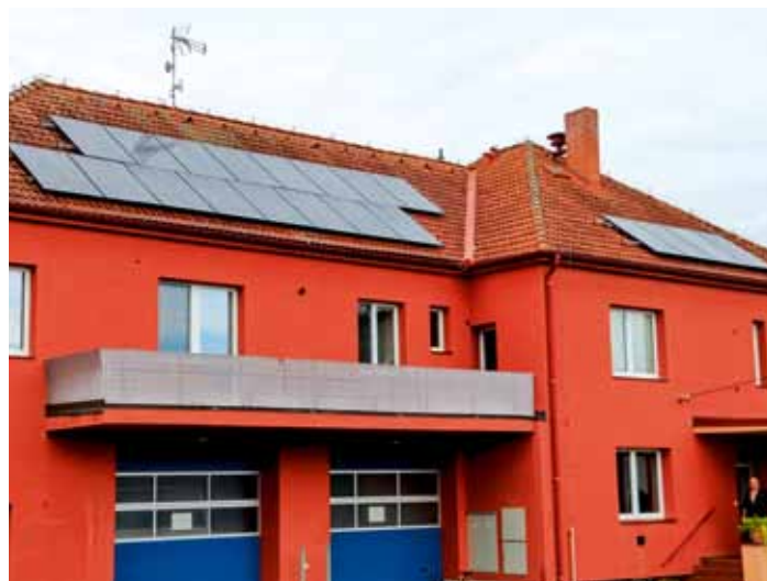
Instalace fotovoltaických panelů pokračuje na budově hasičů – říjen 2025
