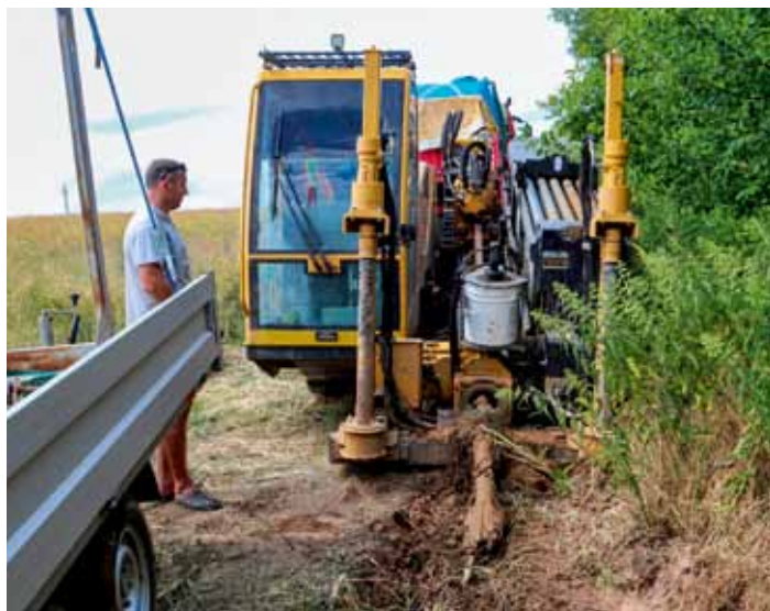
V červenci byla zahájena výstavba nového vodovodu pro Ošťovice metodou protlačování potrubí
