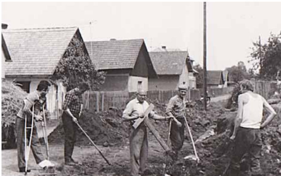
Rok 1976, na Svobodíně se buduje svépomocí kanalizace
