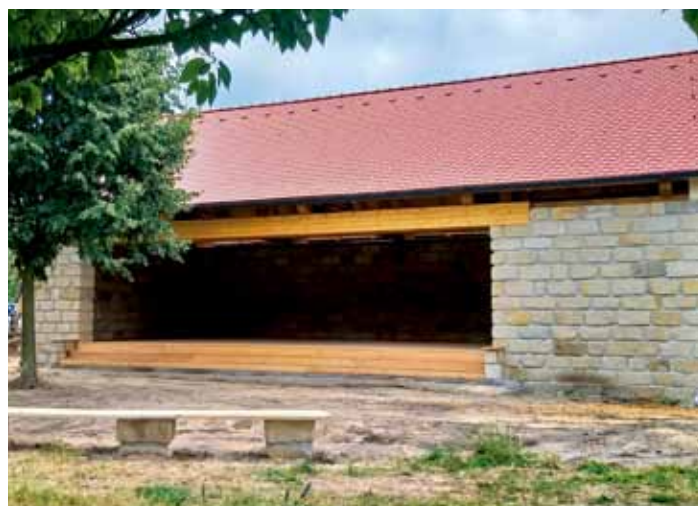
Venkovní pódium za infocentrem - práce jsou ve finiši - červenec
