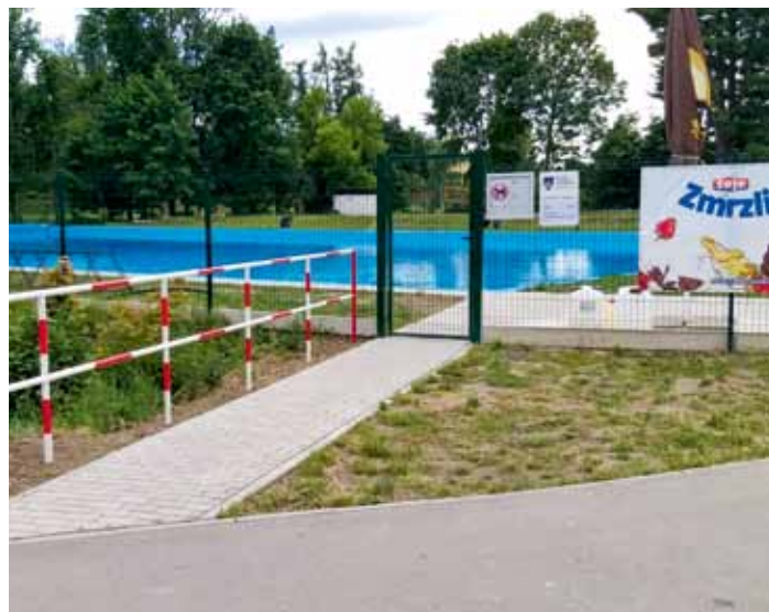
Koupaliště je po rekonstrukci opět v provozu
