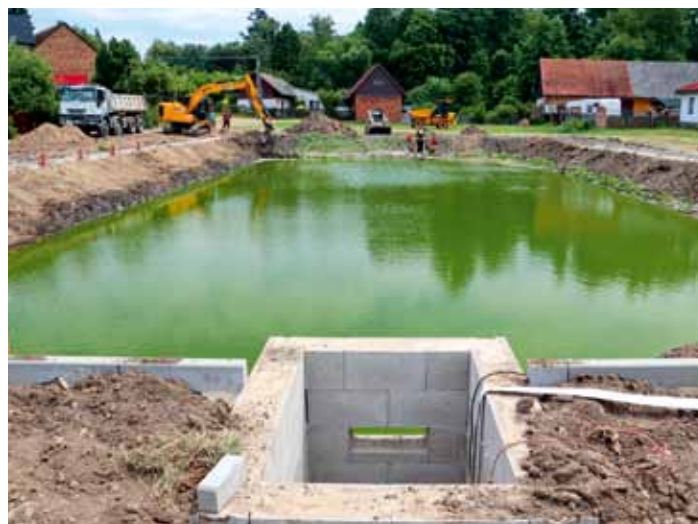
Vlčí Pole - rekonstrukce vodní nádrže pokračuje dle plánu - červenec
