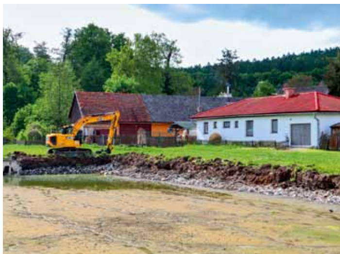
Vlčí Pole - fa Svoboda začala bourací práce na vodní nádrži
