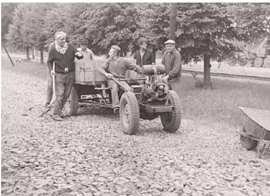
Budování asfaltové cesty na Svobodíně, 1972
