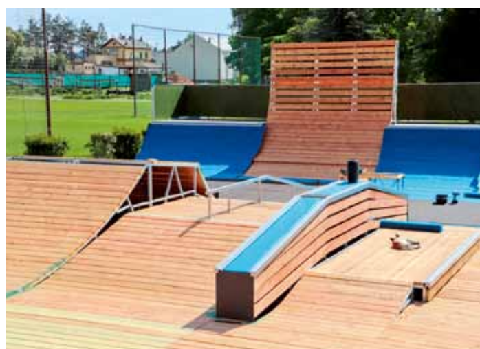
V areálu fotbalového stadionu se dokončuje stavba skateparku
