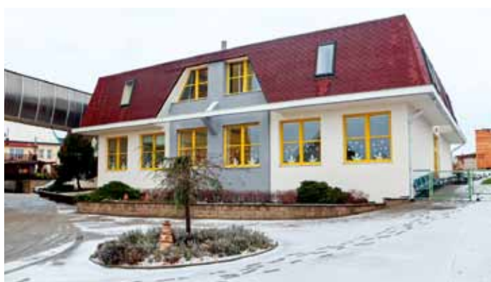
Sportovní hala má novou fasádu. Na jaře, případně dle počasí se ještě vybuduje venkovní zádveří pro komfortní vstup do haly.
