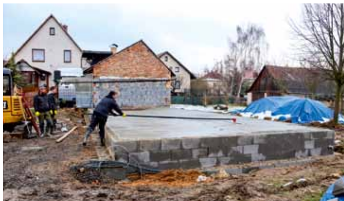
Pro stavbu venkovního pódia u knihovny je dokončena základová deska. Realizaci stavby provádí firma VK Stavby P. Vacek.
