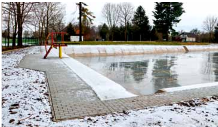
Kolem koupaliště byla dokončena pokládka zámkové dlažby a terénní úpravy. Na jaře dojde k osetí trávy a k nátěru bazénu.
