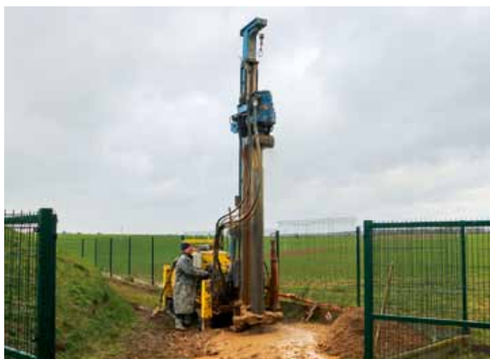
U vodojemu v H. Bousově probíhá zkušební vrt pro případné zálohování stávajícího vrtu ve Střehomí
