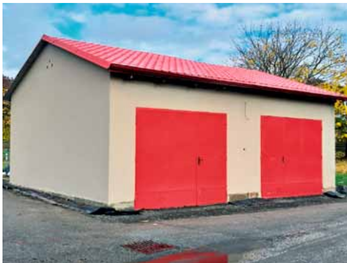
Bechov - hasičárna má novou fasádu. Práce na obou invest. akcích prováděla firma Pavel Vacek VK-STAVBY
