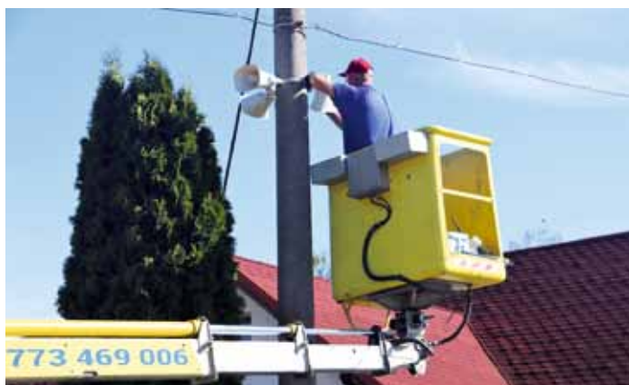
Firma Empemont instalovala digitální bezdrátový rozhlas
