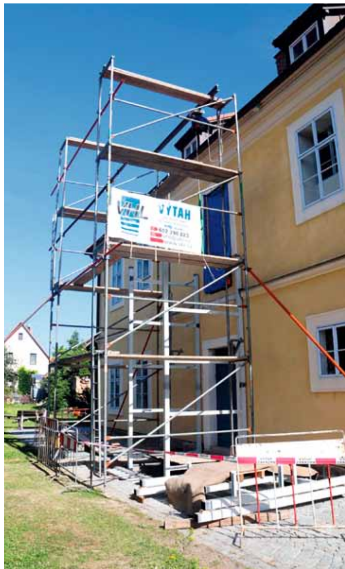
Knihovna, infocentrum – v květnu 2022 začala firma VHL stavbu venkovního výtahu.
