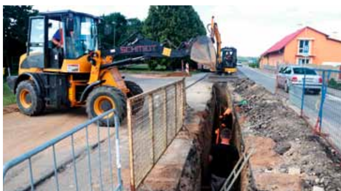
Prodloužení kanalizace, pitné vody a veřejného osvětlení v ulici Přihonská proti benzinové pumpě. Firma Svoboda červen – červenec 2022
