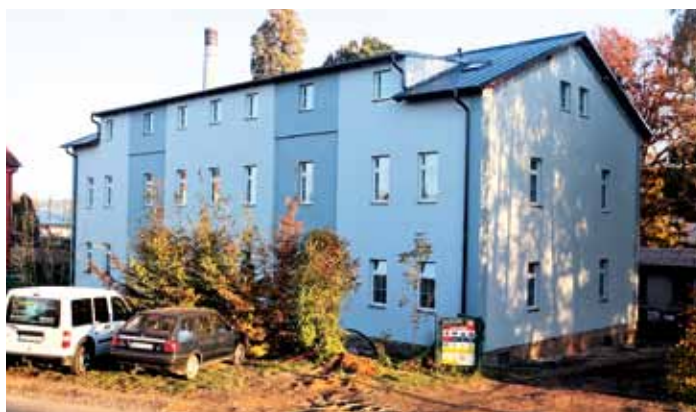
Říjen 2021 – budova po ČS armádě v Tovární ulici má nový kabát.
