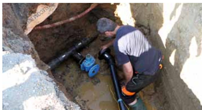
Červen 2021 – napojení nové přípojky vodovodu k novým parcelám od Krajčoviců na Zahrádkách
