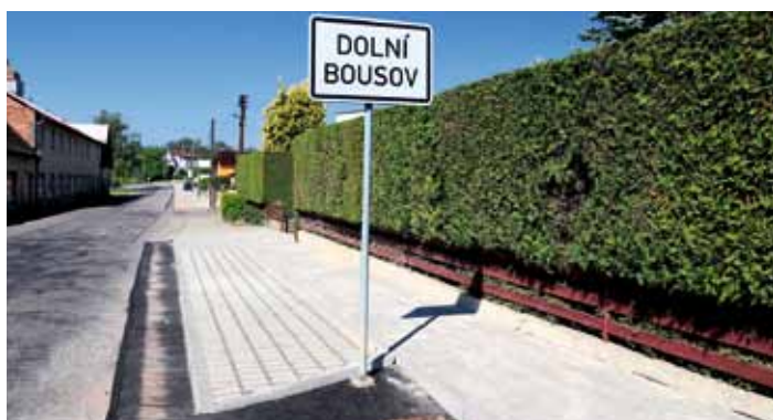
Červen 2021 – chodníky v Tovární ulici jsou dokončené
