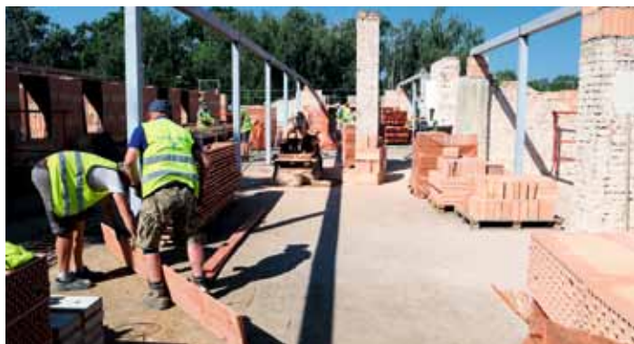
Červen 2021 – č.p. 179 práce na nových půdních prostorech
