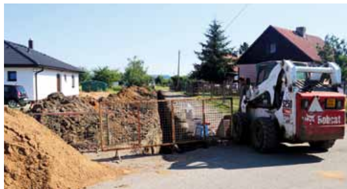
Červen 2021 – firma SVOBODA prodloužila splaškovou kanalizaci na Zahrádkách
