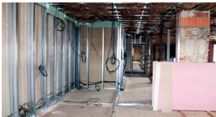
Červenec 2021 – č.p. 179 zateplení střechy, příprava na sádrokartonové příčky a elektroinstalace
