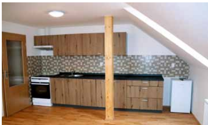
Jsou dokončeny 3. malometrážní byty v č.p. 186 v podkroví MŠ
