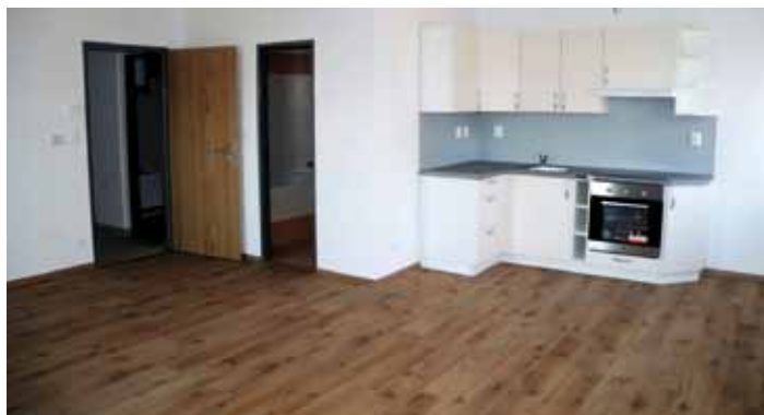
Třináct soc. bytů je komplet hotovo a připraveno k nastěhování
