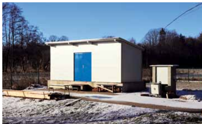
Střehom - přestavba budovy čerpací stanice pitné vody
