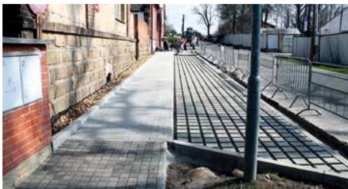
květen 2021 - budování nového chodníku v Tovární ulici
