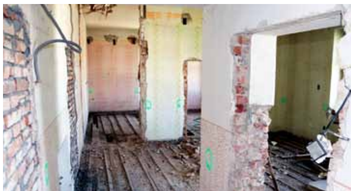
květen 2021 - začala rekonstrukce objektu č.p. 179 na 13 sociálních bytů v Tovární ulici
