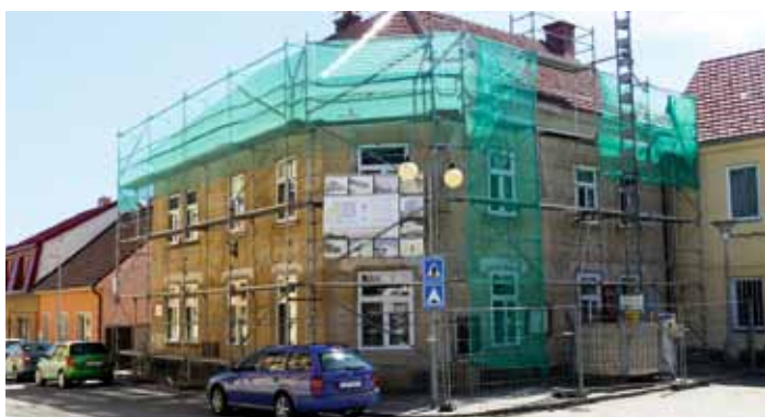
květen 2021 - začala rekonstrukce 3.NP č.p.186
