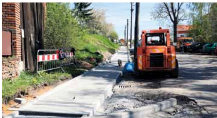
Práce firmy Colas a.s. na novém chodníku v Tovární ulici
