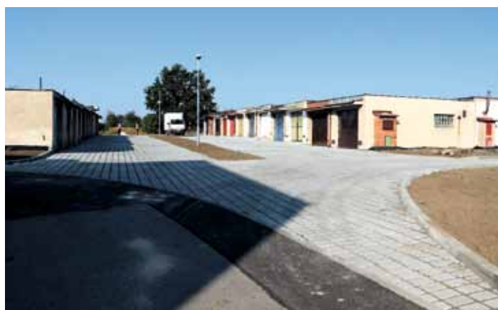
Revitalizace sídliště na Příhoně, povrch kolem garáží.
