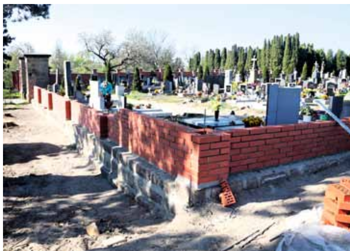
III. etapa oprava hřbitovní zdi.
