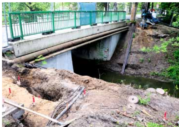
Stará lávka odstraněna, nově se budují základy.
