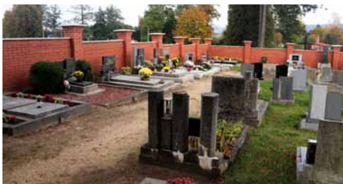
Dokončena oprava III. etapy hřbitovní zdi v D. Bousově.
