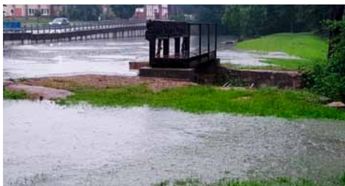
Červnová povodeň se prohnala Továřenskou nádrží, kde přetékala voda přes břehy.
